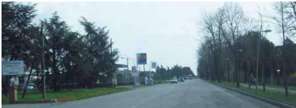
Schermature con specie incongrue o insufficienti
